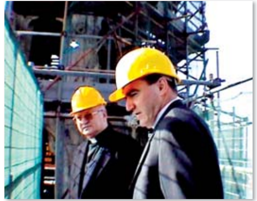
Mons. Klarić s nadbiskupom Bozanićem na gradilištu obnove katedrale, 1998. g.
